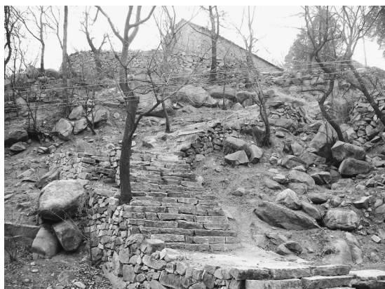
写真1 天勝寨への坂道
