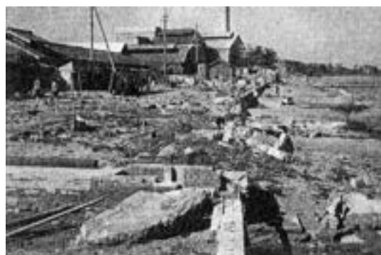
写真④ 砂堆（砂丘）上に建つ工場
