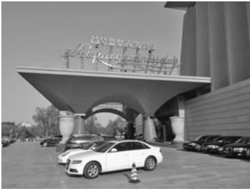
写真1 8号温泉商務会館(外観)
