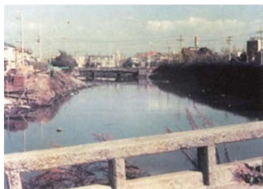
写真 1 1970 年頃の内川（出典：堺市）
