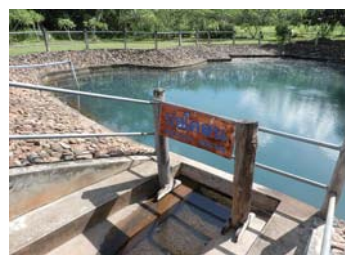
写真9 マッドスパの源泉池
