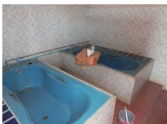
写真10 マッドスパの個室浴場（工事中）
