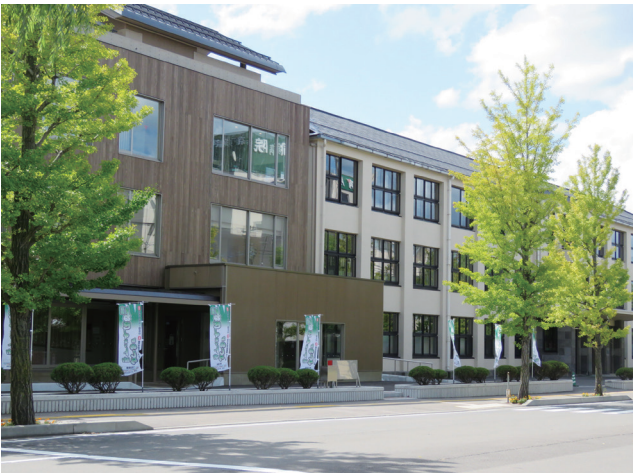
写真－3 能代市役所第一庁舎外観 (上：新庁舎建設前、下：現在は新庁舎と接続)
