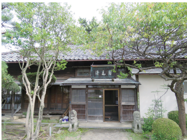
写真－5 清亀園外観
